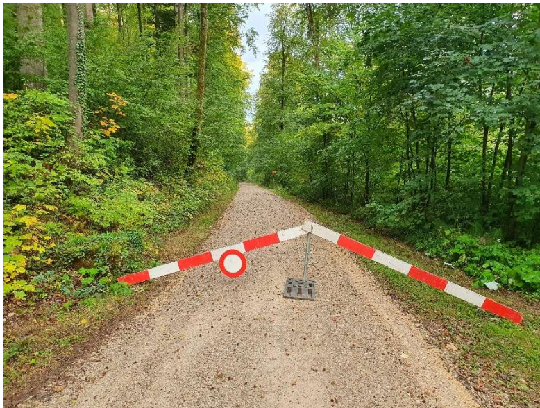
Abbildung 2 Frisch überführte Mangelstrasse
