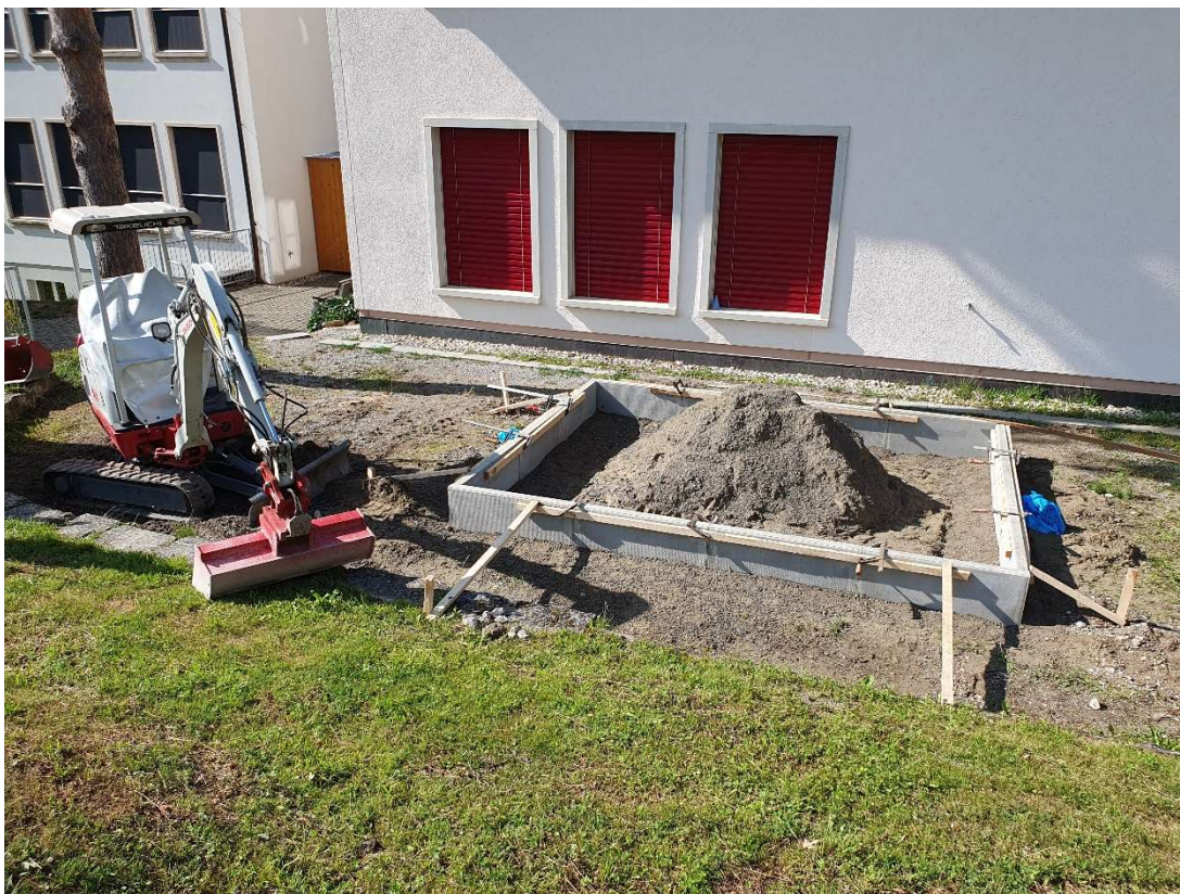
Abbildung 4 Kleinbagger neben neuem Sandkasten
