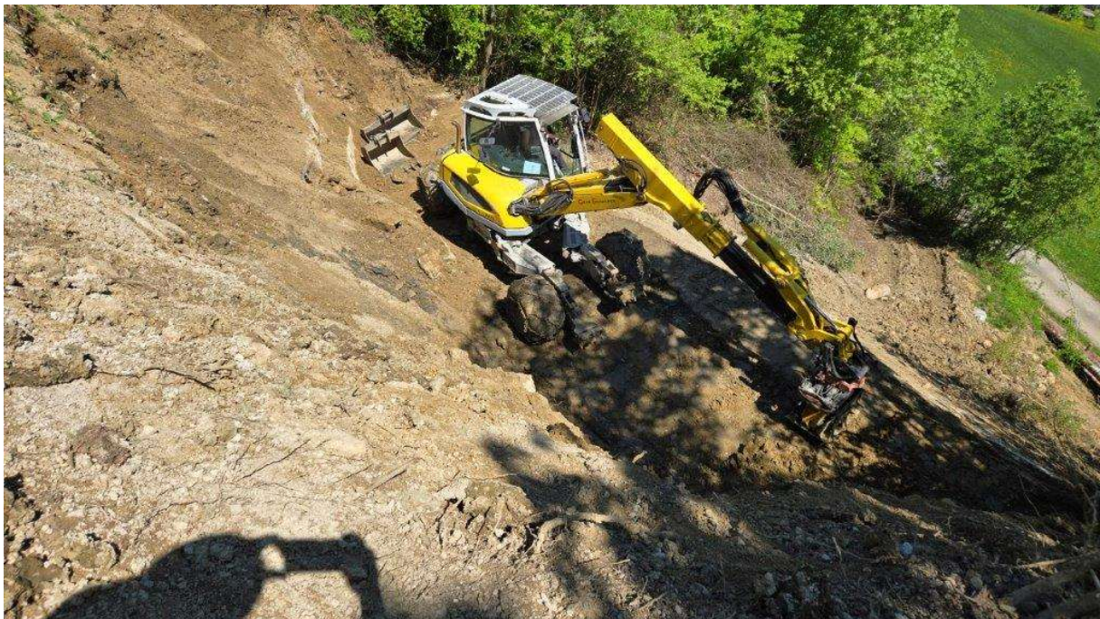
Abbildung 2 Sanierung Hangrutsch Galterhölzli
